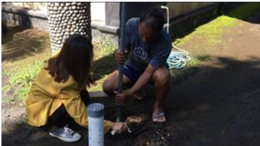
Gambar 1. Pembuatan Lubang Biopori
